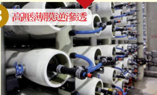
自然情況下，當濃度高的海水與淡水用半透明薄膜隔開，純水會因滲透壓滲入海水端。而逆滲透即是用高壓在海水端施壓，迫使海水因逆滲透壓流入純水端，強迫鹽水分離的技術。
