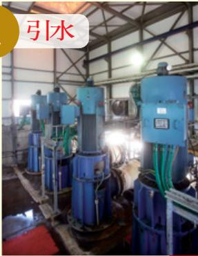
每一分鐘從海水表層引入300噸的海水，消耗的電能極大，整座廠有37%的電力用於引入海水。
